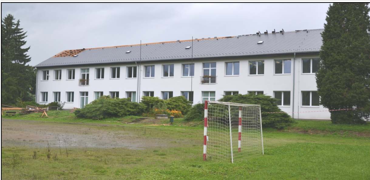
Foto: Budova základní školy se dočkala nové střechy. Práce probíhaly od 1. srpna do 20. září. Na akci získala obec dotaci 3 mil.Kč.
