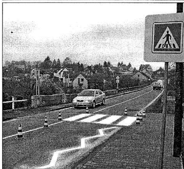
Foto: Nový přechod s chodníčkem v Benešovské ulici
