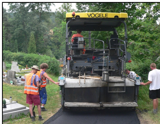
Foto: Oprava komunikace na hřbitově
