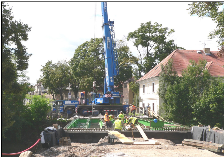
Foto: U obecního úřadu v Čerčanské ulici roste nový most přes Konopišský potok
