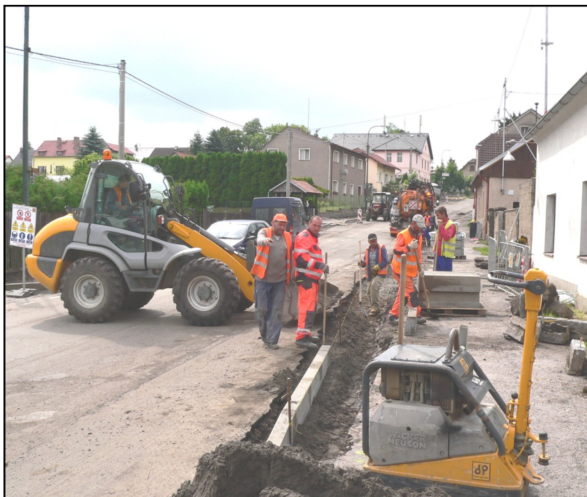
Foto: Výstavba nového chodníku a místa pro přecházení v Pražské ulici
