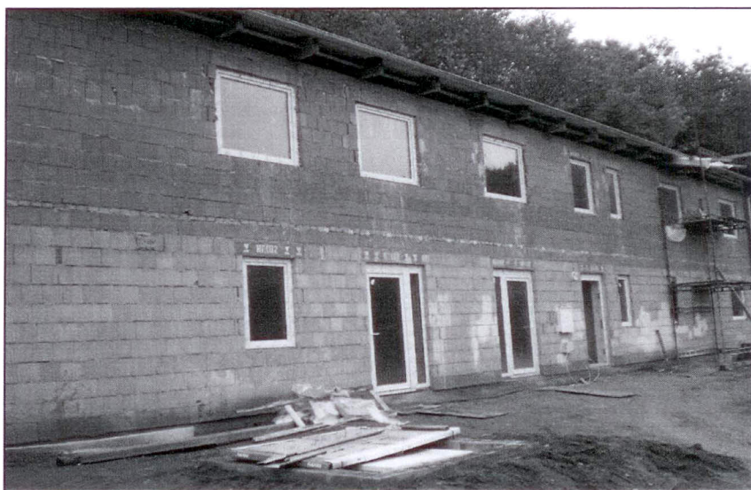
Foto: Snímek z probíhající rekonstrukce fotbalových kabin v Potočinách
